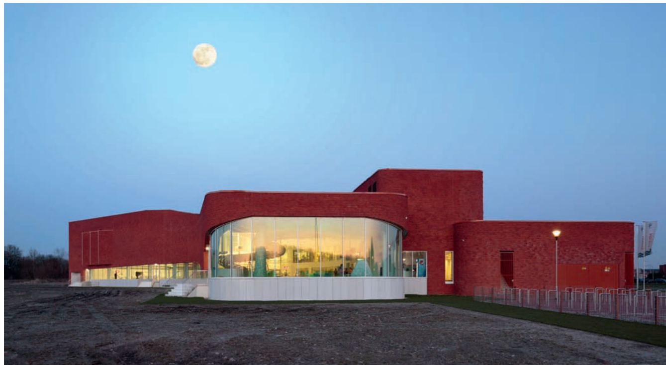
■ Complexul de recreație, Hofbad Aquatic Centre, Haga, Olanda 2012 / foto: Ronald Tilleman
